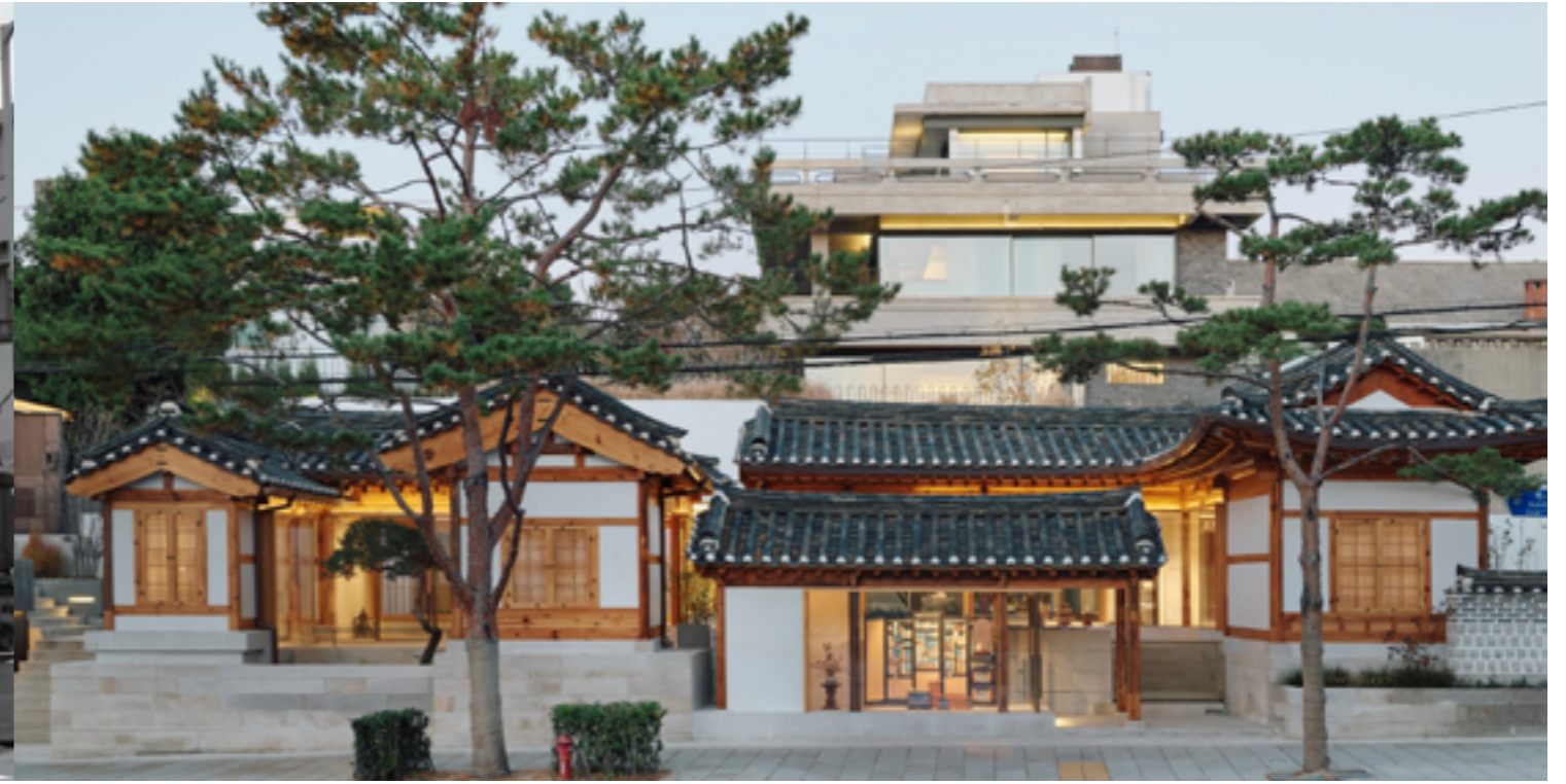
북촌 설화수의 집, 공사 후
