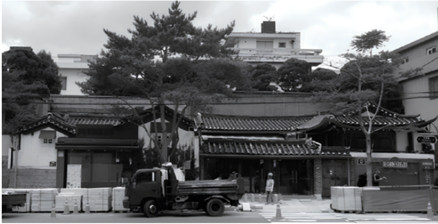
북촌 설화수의 집, 공사 전
